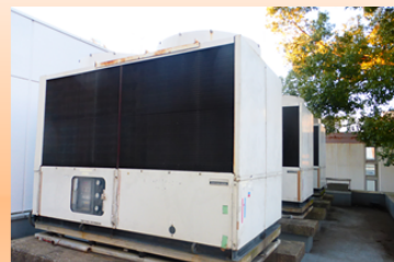
更新予定のポストロン棟チラー。設置から32年が経過し、既に部品供給が停止している。
