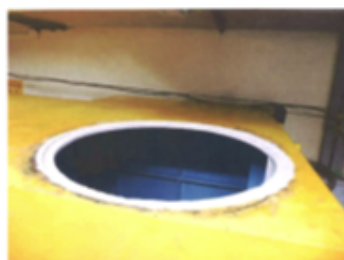
写真4 給水用マンホール開口部 メンテナンス前後
