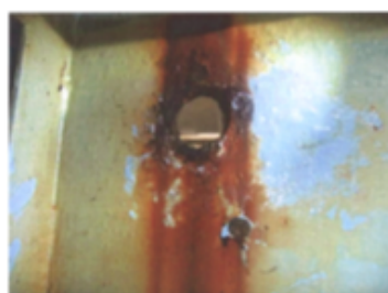
写真2 駆動軸受けフランジ部内側 メンテナンス前後
