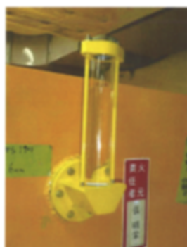
写真3 水位計 メンテナンス前後
