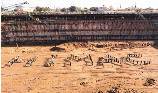
HIMAC棟建設現場における「HIMAC」人文字
