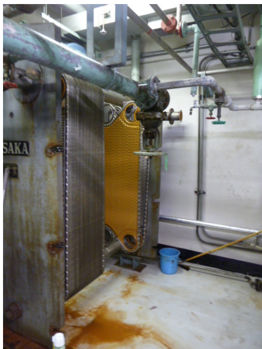
図 5. プレート熱交換器（分解中）。
