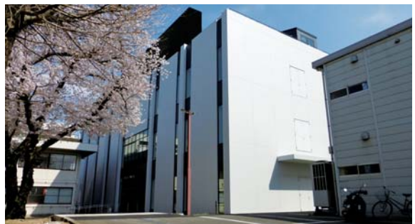
図10 環境放射線影響研究棟(2014年3月竣工)
