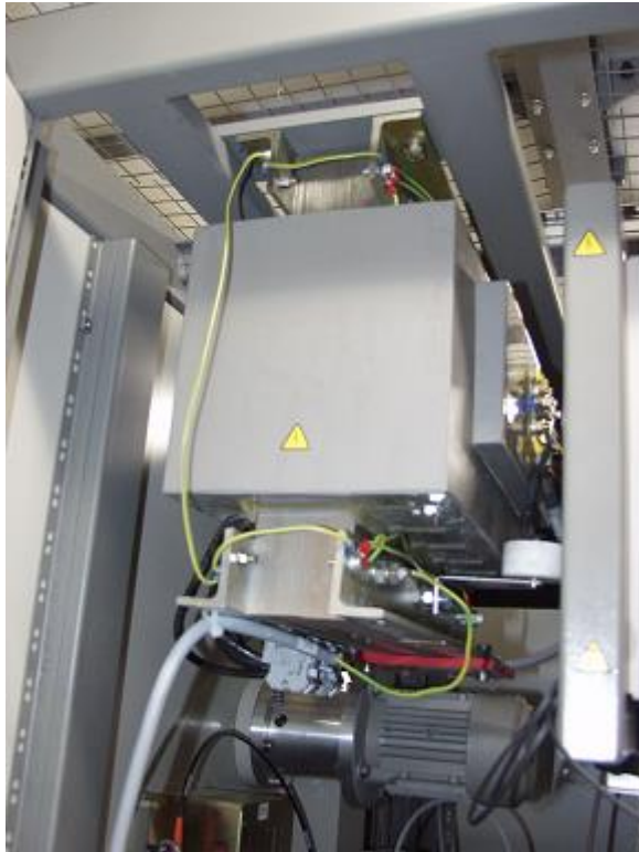
図 11. 交換前の絶縁トランス
