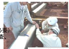
工場での鉄骨検査
