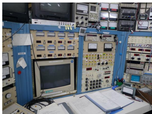
図 6.加速器の制御システム
