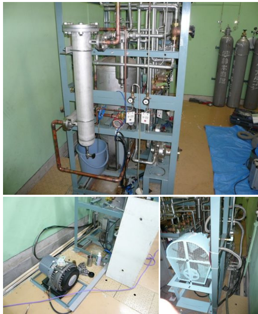
図 13. \text{SF}_6 回収装置の改造
