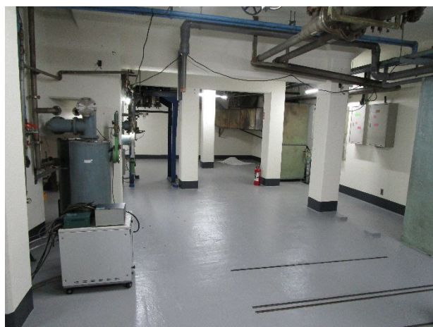
図 9. 塗装後の電源室(北側)
