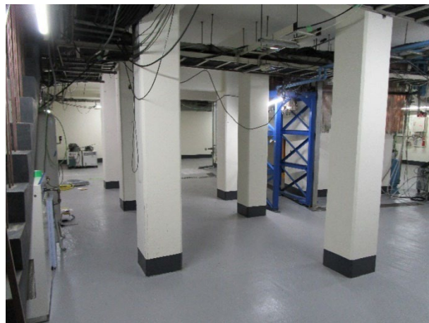
図 7. 塗装後の電源室(南側)
