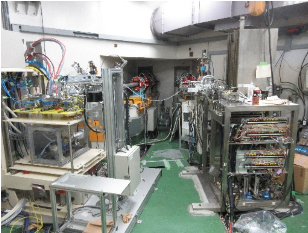
写真 4. 改修後の RI 生産照射室
