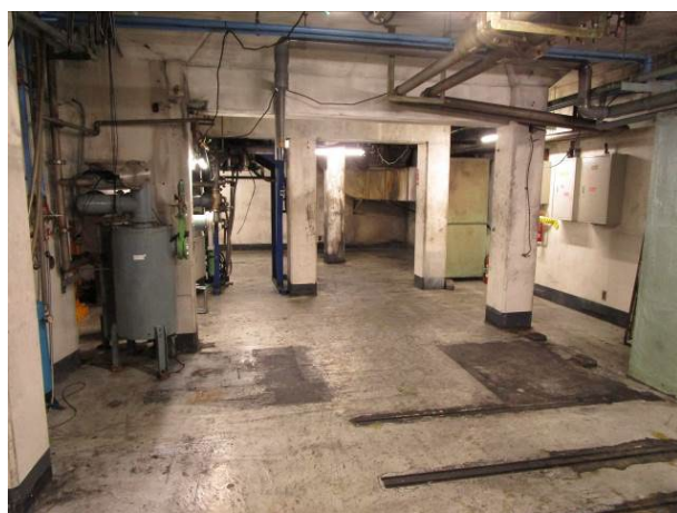
図 8. 塗装前の電源室(北側)
