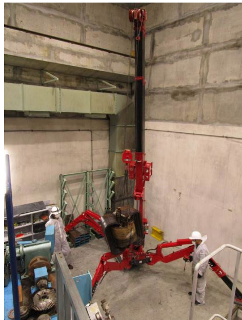
図14. トランスを吊り上げるカニクレーン
