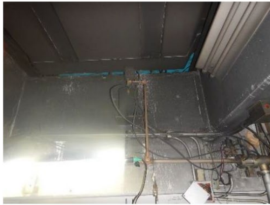
電源室の天井 作業前
